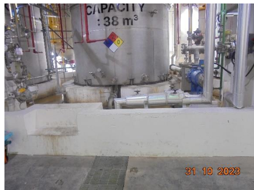
รูปที่ 14 ภาชนะรอง/คันคอนกรีตรอบถังบรรจุน้ำมัน
